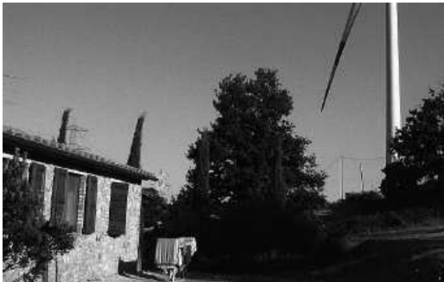
Le pale eoliche nella zona di Scansano. Una di esse è stata danneggiata da un fulmine
